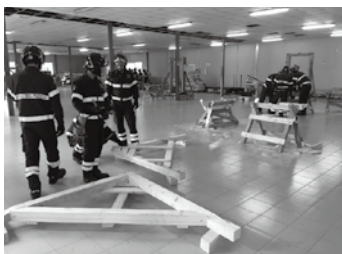
⑥ イタリアの消防隊の応急補強訓練
