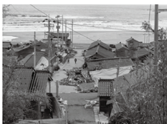
① 黒島地区の被害状況
