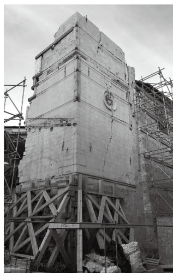
⑦ イタリアの応急補強の事例
