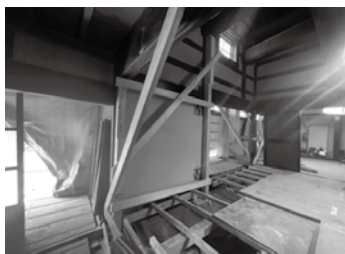
③ 添え柱と木製筋かいによる応急補強
