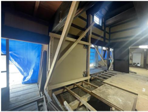
図 12 輪島市黒島地区の応急補強の事例
