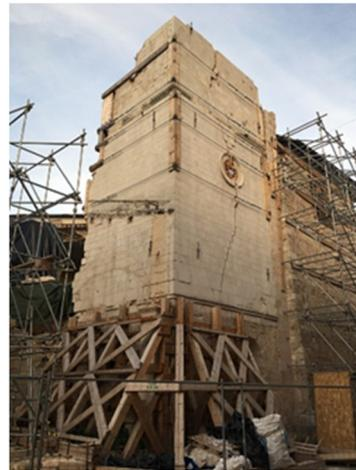
図 13 イタリアにおける応急補強の事例
