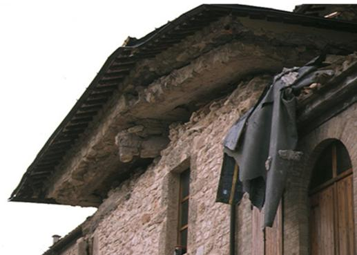
図4 イタリアの現代構法補強の被害事例
