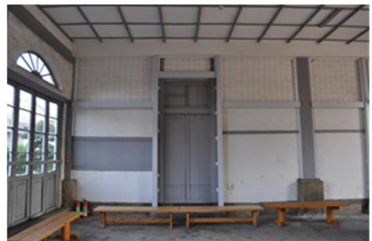
図3 富岡製糸場東置繭所の経過的補強
