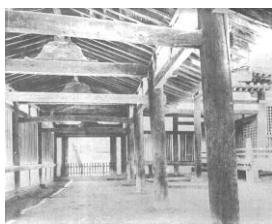
写真2 昭和修理前の補強 1)
