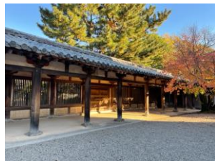
写真1 法隆寺東院廻廊
