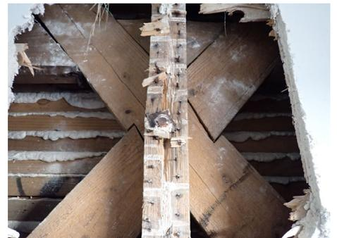
図3 部分解体調査(筋違接合部)
