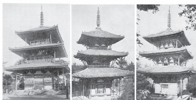
a. 法起寺三重塔
