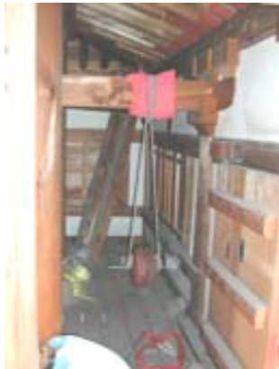
写真 5 振り子の設置状況
