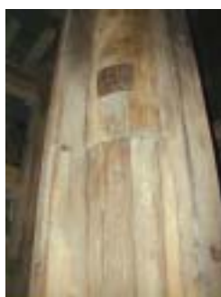
写真1 心柱継手(5層目付近)
