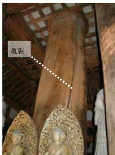
写真 7.2 心柱根元の亀裂
