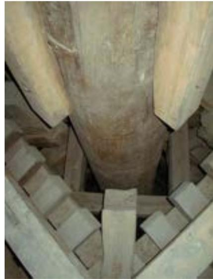
写真 9.1 心柱の二層上部に残る圧痕
