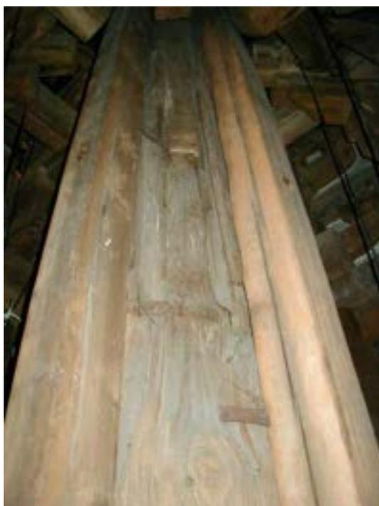
写真 1 心柱継手（北東面）
