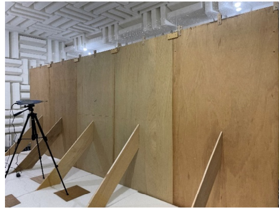
画像8 有孔板とベニヤ板の遮音壁 (受信側)
