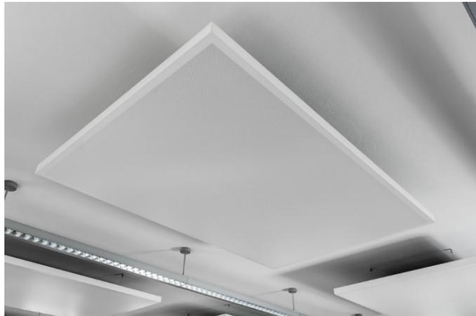
Fig. 1 天井設置型 MPP 吸音体
