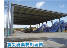
震災廃棄物処理場
