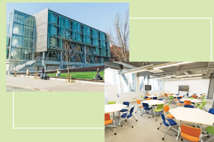
イノベーション創生センター
